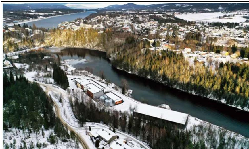
Skandaleprosjekt: Renoveringen av renseanlegget i Bårlidalen tok mye lengre tid enn planlagt og sluttregningen ble langt dyrere enn budsjettert. Hittil er regningen kommet opp i 290 millioner kroner, forteller rådmann Knut Haugestad. Foto: Bjørn Hytjanstorp
